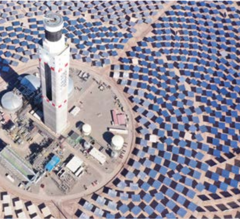
Credit: Abengoa/Acciona/Cerro Dominador, Cerro Dominador project, Chile
