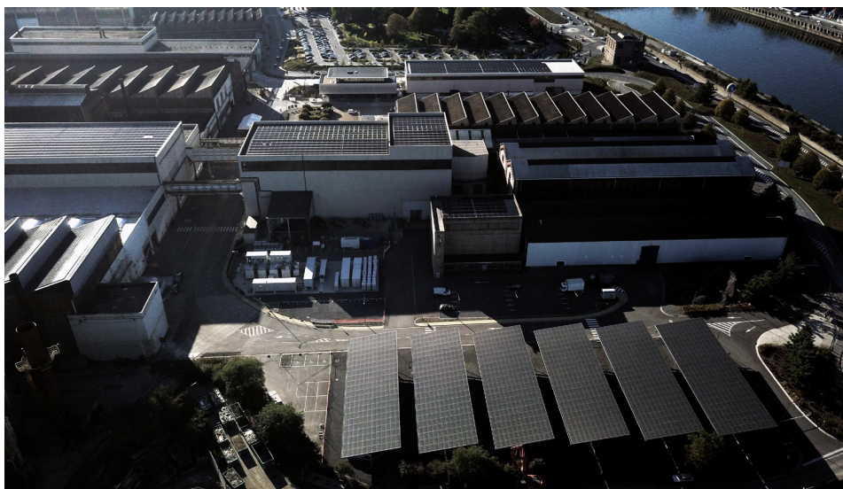
Les toits des ateliers de John Cockerill sont équipés de 6.500 m2 de panneaux photovoltaïques.
